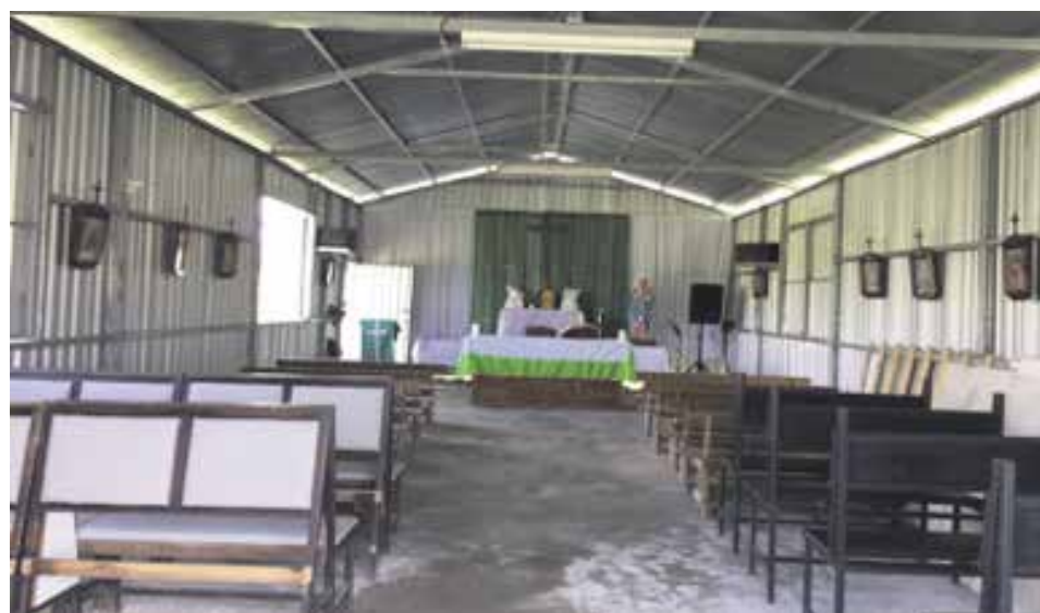
I lavori di costruzione e completamento della cappella in Costa Rica
