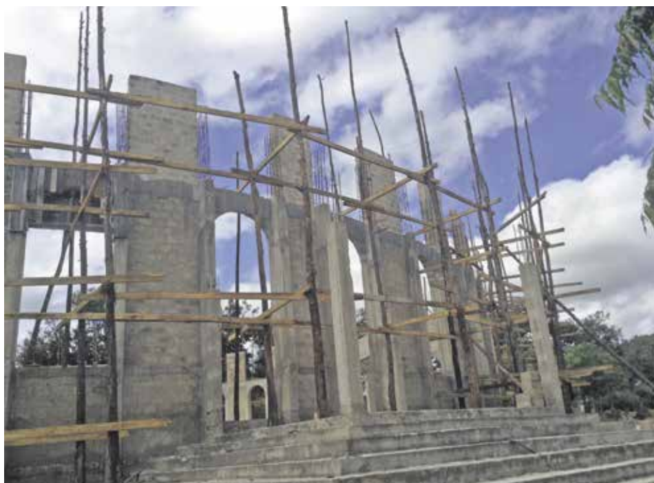
Il progetto della chiesa di Bukombe (Tanzania) intitolata a S. Giuseppe: lo stato attuale dei lavori per la costruzione del tetto
