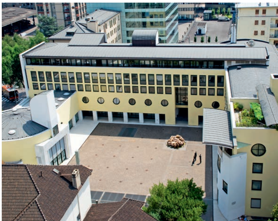
Il Centro pastorale a Bolzano ha un impianto fotovoltaico installato sul tetto
