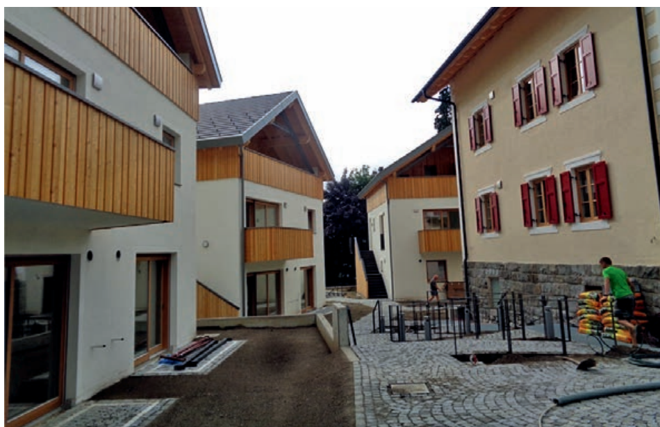
Il complesso residenziale Maria Schutz a Parcines, 14 alloggi di proprietà della Diocesi
